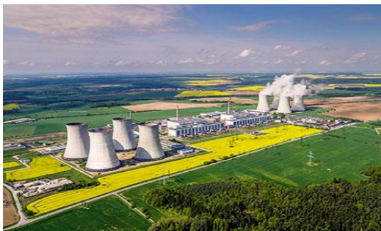
ČEZ, a.s., Jaderná elektrárna Dukovany
