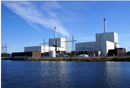
Forsmark NPP, Östhammar, Sweden.
